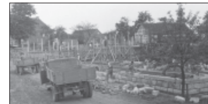
Errichtung der Grundmauern
